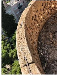
Şekil 6. (a) Lala Mehmet Paşa Cami çekirdekli merdiven görünümü, (b) İbrahim Çelebi Cami ait şerefe bölümünün alt, konsol, korkuluk ve kenet bağlantı görünümleri, (c) İbrahim Çelebi Cami petek bölümüne ait seren elemanı
