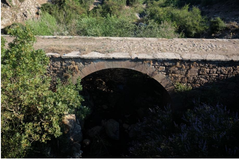
Foto 24: Geleneksel köprünün üstünün betonarme kaplanması
