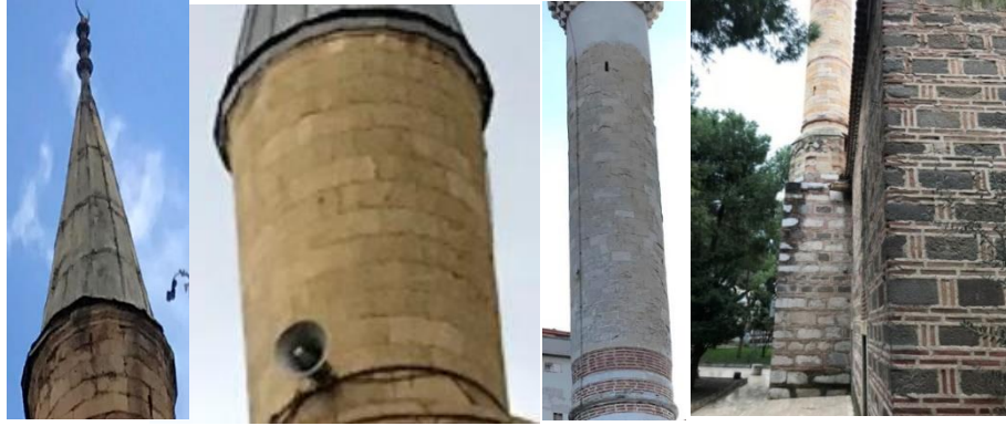
Şekil 2. (a) İbrahim Çelebi Cami alem ve külah bölümü, (b) Lala Mehmet Paşa Cami petek bölümü dış görünümü, (c) İbrahim Çelebi Cami gövde bölümü, (d) İbrahim Çelebi Cami kaide bölümü
