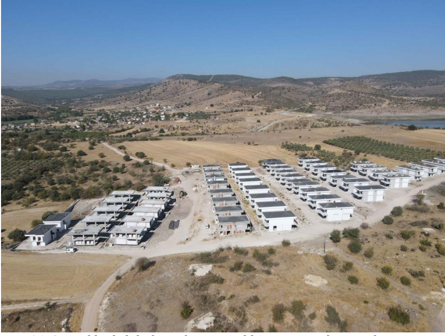
Foto 16: Site şeklinde lüks konutların yer aldığı ve inşası devam eden
