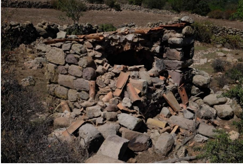
Foto 15: Çatı malzemesindeki deęişim
