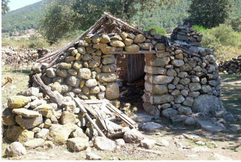
Foto 6: Yapının ön cepheden görünüşü
