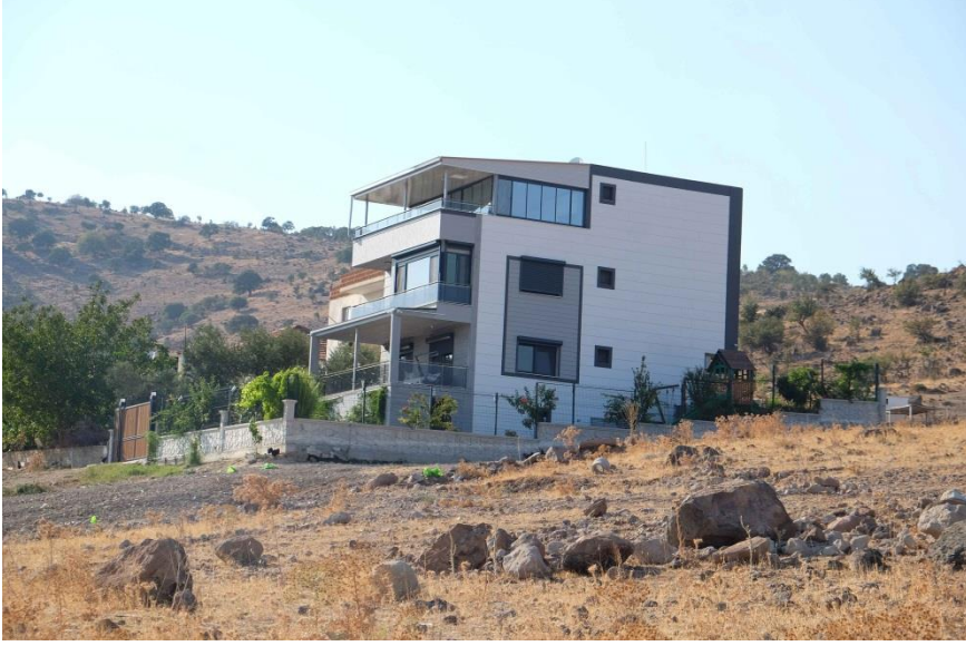
Foto 14: Sahada yeni inşa edilmiş bir yapı
