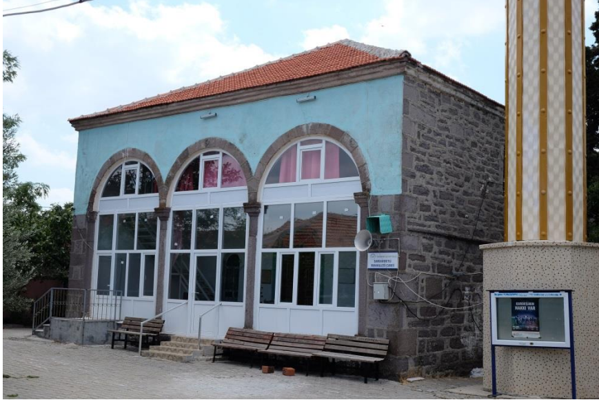
Foto 21: Mimari yapıya uygun olmayan eklemelerin olduğu bir cami
