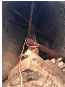
Şekil 6. (a) Lala Mehmet Paşa Cami çekirdekli merdiven görünümü, (b) İbrahim Çelebi Cami ait şerefe bölümünün alt, konsol, korkuluk ve kenet bağlantı görünümleri, (c) İbrahim Çelebi Cami petek bölümüne ait seren elemanı
