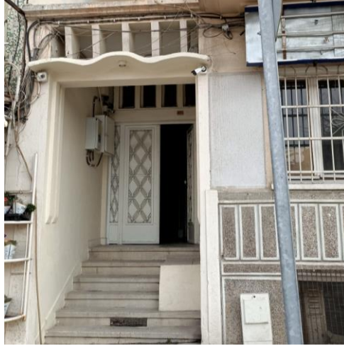
Şekil 7. Yapının giriş detayı
