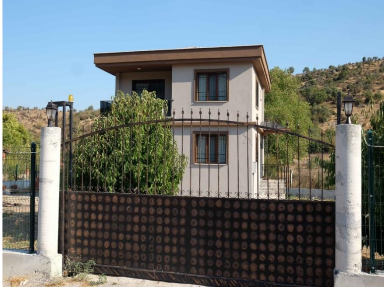
Foto 15: Etrafı tellerle çevrilmiş bir yapı
